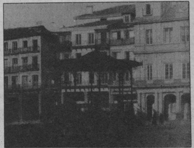
Otra fotografía antigua del kiosco, cuya reconstrucción no es posible; habrá que instalar uno nuevo
