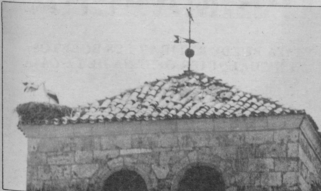
En las fotografías se aprecia el estado actual de la fachada y de la cubierta de la torre. (Fotos: Aurelio M.)
