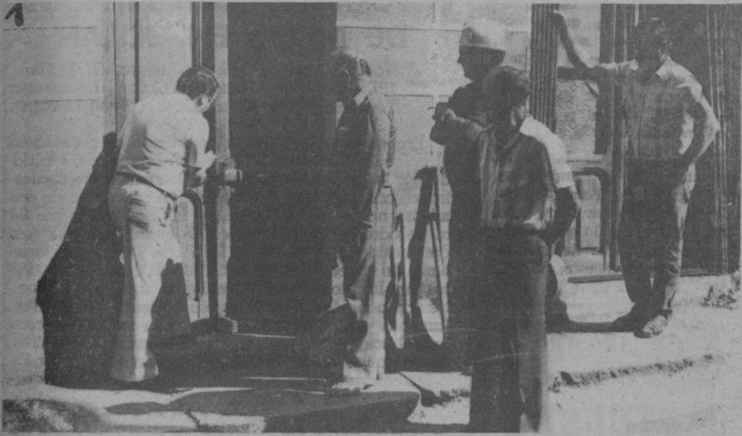
Uno de los inquilinos abre el acceso al edificio a los obreros municipales.
