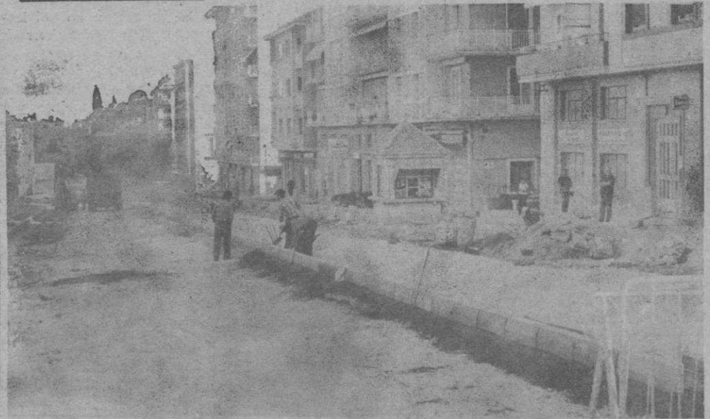
He aquí el primer tramo del Paseo Nuevo en el que, conforme al proyecto en ejecución, aparece ya dividida la calzada por un bordillo. Esta separación de calzada se ha colocado ya en el Paseo de Ezequiel González, es decir, entre el puente de Sancti Spiritu y el estacionamiento de autobuses.
