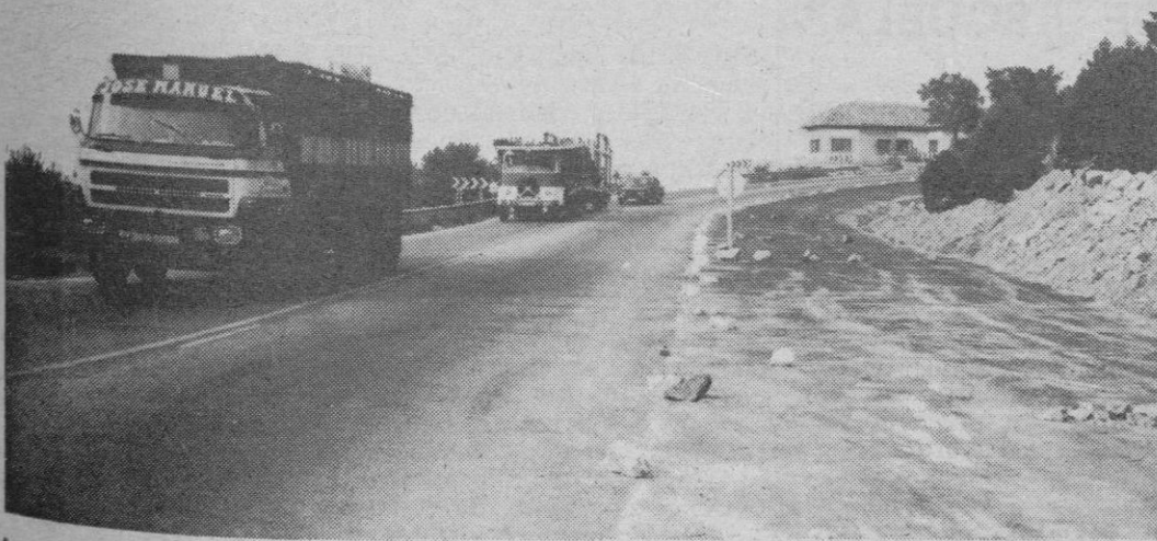
Arriba, el desarrollo de las obras de la vía lenta por el lado de Segovia. Abajo, se aprecia a la derecha el nuevo tramo lento.
