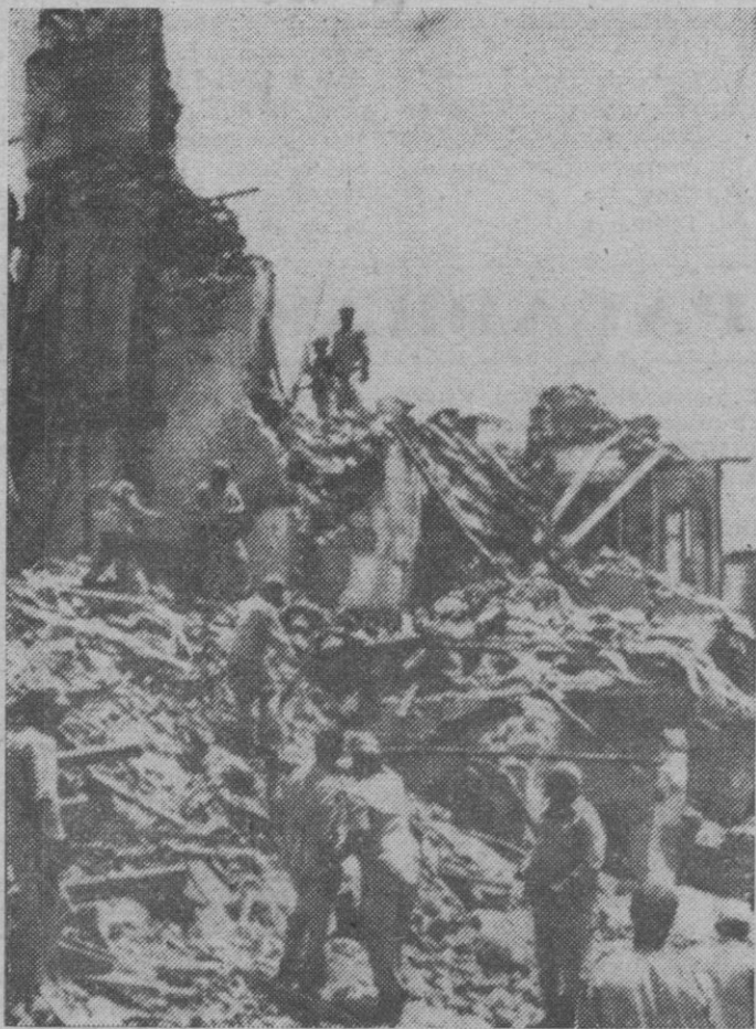
Un antiguo edificio situado en un distrito de trabajadores de El Cairo se ha derrumbado. Unas veinticinco personas resultaron muertas.
