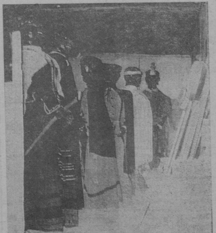
También el edificio está destinado para almacenar efectos municipales, como los viejos gigantes y cabezudos aparte de señales de tráfico, etcétera
