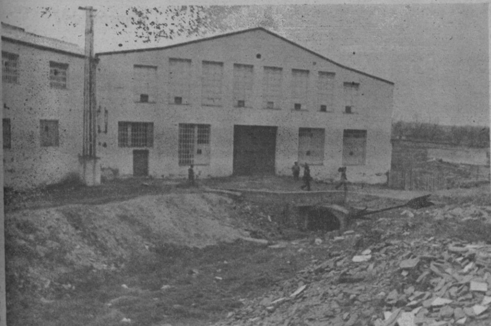
Junto a la fachada posterior de un secadero de jamones existente a un lado de Celese, aparece la boca del túnel de cobertura del arroyo Clamores, por la que parece escaparon los 29 presos políticos.—(Foto Antonio)
