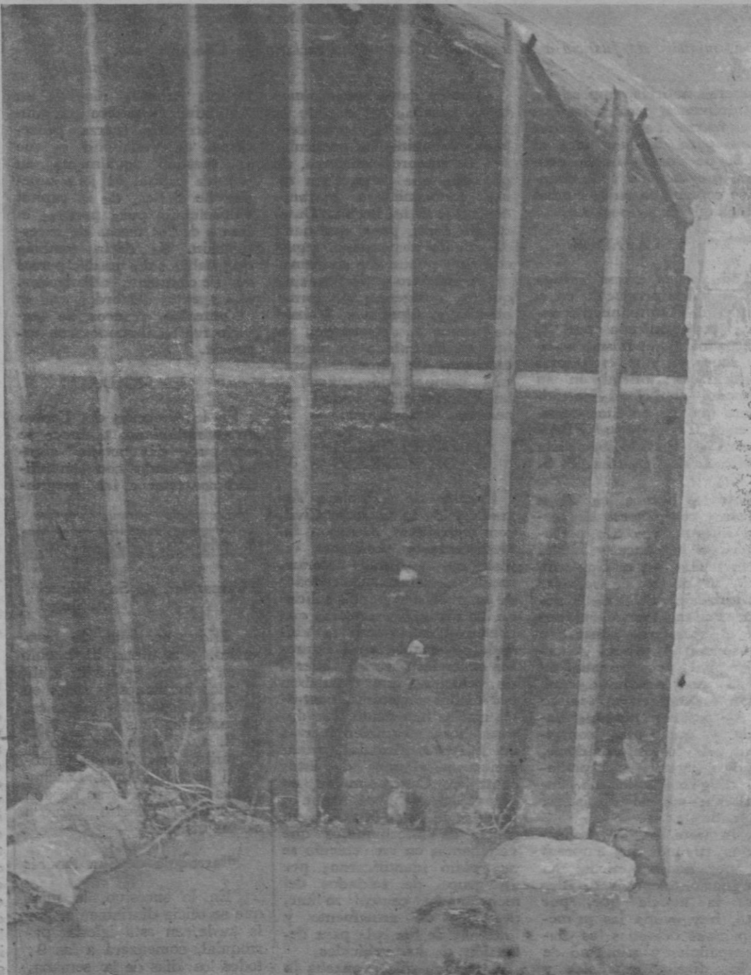
Con detalle puede apreciarse en la fotografía el barrote aserrado, que dejó hueco suficiente para permitir la escapada.—(Foto Antonio)
