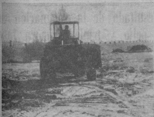
Una máquina trabajando en la explanación del terreno
