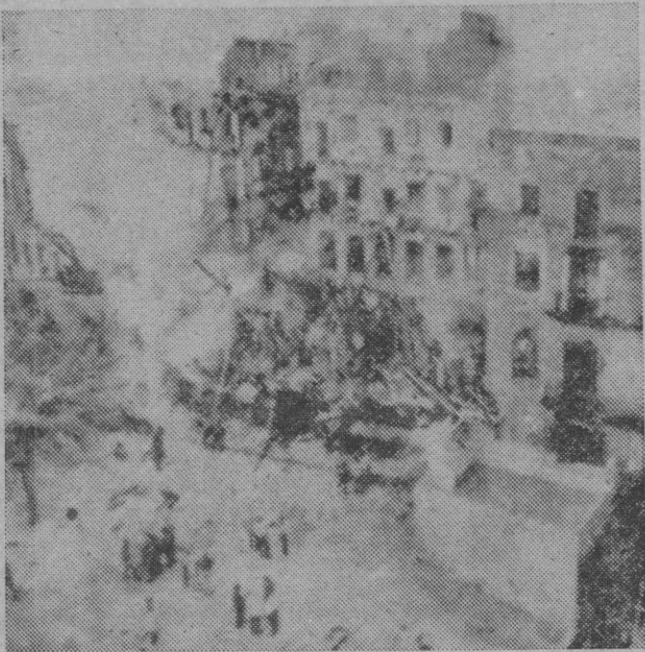
Vista de varios de los edificios afectados por el incendio
