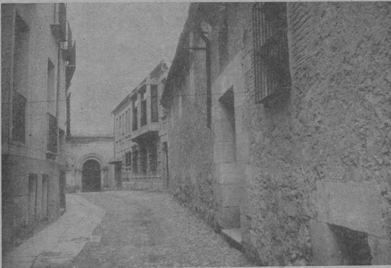
Tramo de la calle de Velarde. Al fondo la portada románica lateral derecha al arco o portillo de La Clastra, perímetro que llegó a cortar con cuatro puertas, de la que sólo se conserva ésta, al ser demolidas las anteriores con motivo de las bodas de don Felipe II con doña Ana de Austria, celebradas en el Alcázar. Este recinto gozó en tiempos medievales de impunidad para los delincuentes, que se refugiaban cometidos sus delitos amparándose en el entonces vigente «Derecho de Asilo»
