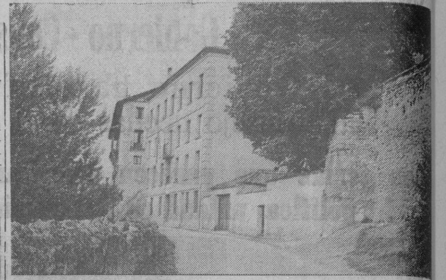
Fachada posterior del actual edificio de la Asamblea Provincial de la Cruz Roja segoviana, en la que tiene su acuartelamiento la Brigada de Tropas. Este edificio va a ser ampliado en parte, a fin de que las nuevas dependencias sirvan para la Cruz Roja de la Juventud y otros servicios complementarios. —(Fotos Antonio)
