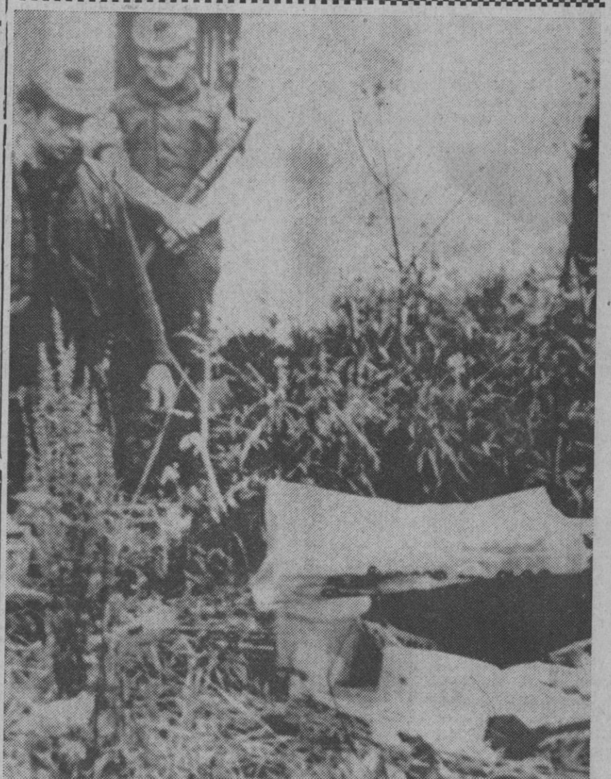
Armagh.—Soldados británicos inspeccionando alrededor de un edificio abandonado cerca de esta localidad utilizado por el IRA como factoría para fabricar bombas terroristas.—(Telefoto AP-Europa Press.)
