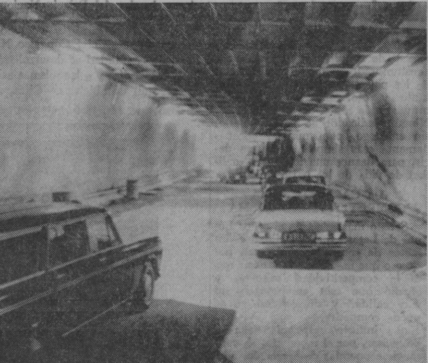
Estado actual del túnel. (Foto Santos Yubero)
