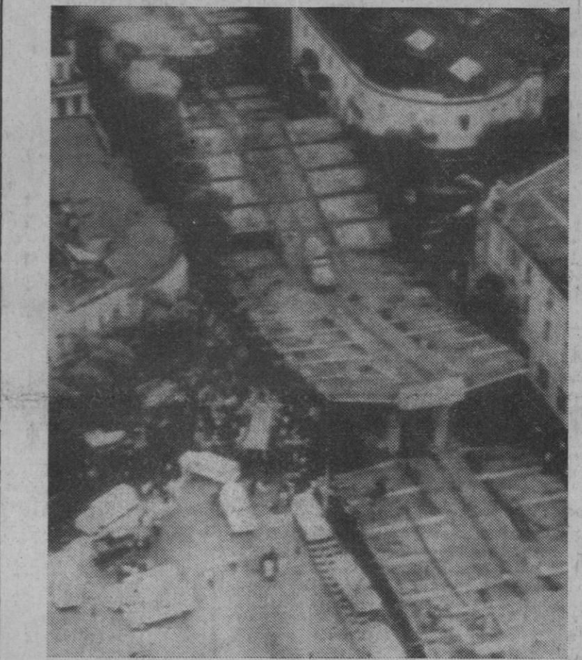
Río de Janeiro (Brasil).—Cerca de 800 toneladas de cemento de un viaducto de la ciudad situado sobre una intersección, se derrumbaron sobre el nivel de la calle. El viaducto que se encontraba en construcción, cedió al paso de un camión-hormigonera.—(Telefoto AP-Europa Press)
