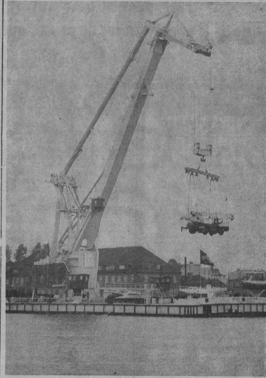
Wilhelmshaven.—Esta grúa flotante de 200 Mp. está destinada para el puerto de Río de Janeiro. Su capacidad de carga máxima la alcanza el gigante con 19 metros de radio de acción. La parte posterior del pontón de 50 por 22 metros de superficie admite una carga de doscientas toneladas...
