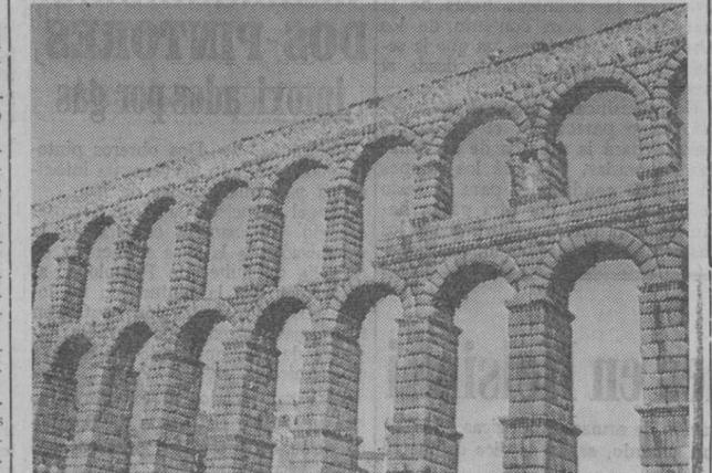
Se han terminado los trabajos realizados para desmontar la tubería que desde hace medio siglo llevaba agua de la red general por la parte superior del acueducto. Ahora, éste queda sin añadidos tal y como le construyeron los romanos, ya que ha desaparecido totalmente además de la tubería y las paredes protectoras de ésta, el murete que iba a todo lo largo del Azoguejo hasta la puerta del Postigo del Consuelo.
