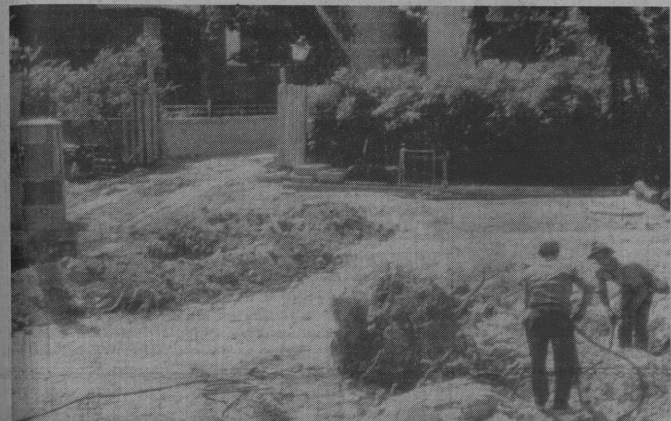
Madrid.—Un grupo de obreros aparece trabajando en el solar adquirido para la nueva sede de la delegación de la Marina Mercante rusa en Madrid. El solar se encuentra enclavado junto al paseo de la Castellana. (Foto Europa Press)
