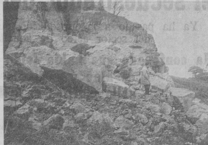
Vista parcial del desprendimiento de bloques, cuyo tamaño puede apreciarse en comparación con la figura.—(Foto Antonio)
