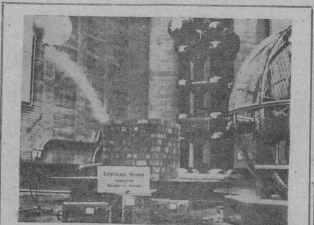
Buscando la forma de amortiguar los ruidos en material de construcción, un técnico, protegido por una jaula faradayca, comprueba los efectos de la descarga de 1,7 millones de voltios contra un cubo de ladrillos de treinta centímetros de espesor en la Superior Técnica de Munich, por encargo de la Federación de Industrias del Sonido bávaro. En primer plano, los aparatos de medición
