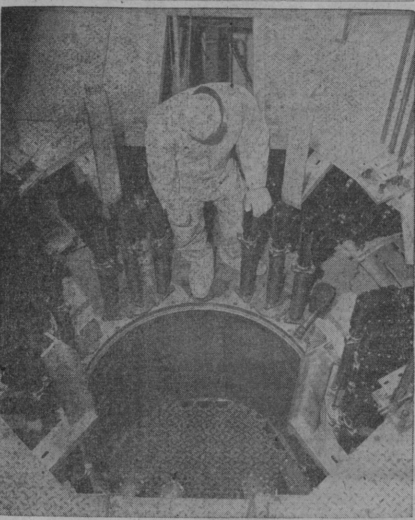
Se encuentran muy adelantados los trabajos de construcción del "Zenith", reactor de energía cero y alta temperatura que se está erigiendo en el establecimiento de investigaciones atómicas de Winfrith Heath, Dorset, Gran Bretaña. En esta fotografía se ve a un especialista trabajando sobre el núcleo del reactor, que ha sido diseñado para llevar a cabo estudios básicos sobre sistemas de alta temperatura moderados por grafito.
