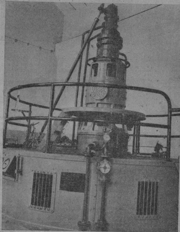
Nuevo grupo de eje vertical con turbina Kaplan de 2.650 H. P. recientemente instalado.
