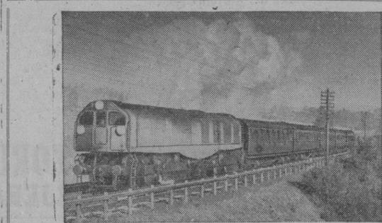
Esta es una nueva locomotora de seis cilindros que tiene como novedad, además de otras varias de carácter meramente técnico, el que el fogonero va en el centro y en cada extremo de la máquina hay una garita para el maquinista
