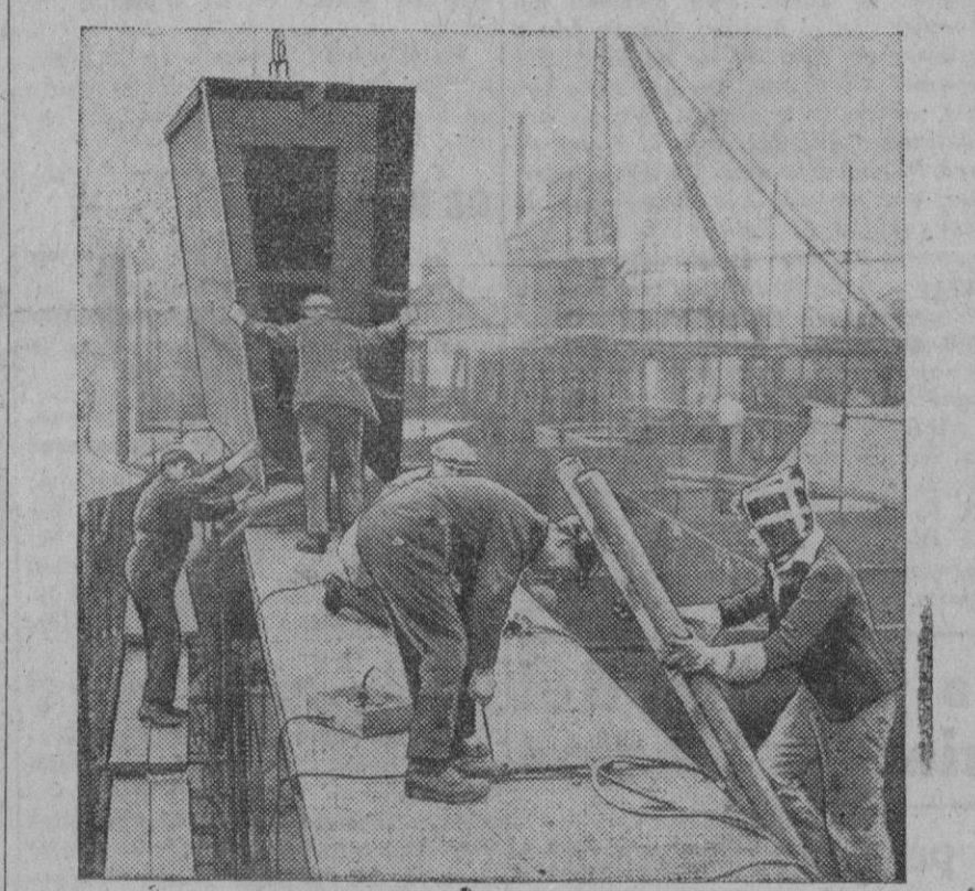
Estos obreros se afanan en la construcción de un barco. Y se limitan simplemente a colocar las piezas en su sitio, porque se trata de un barco prefabricado
