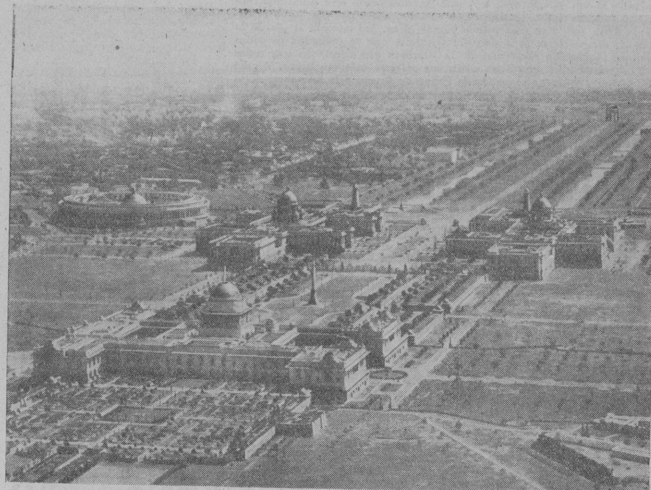
Toda la atención del mundo está concentrada en la capital de la India, Nueva Delhi, de la que reproducimos una fotografía aérea. En primer plano el palacio del virrey. En el centro, los dos edificios del secretariado imperial, y a la izquierda, el Parlamento.
