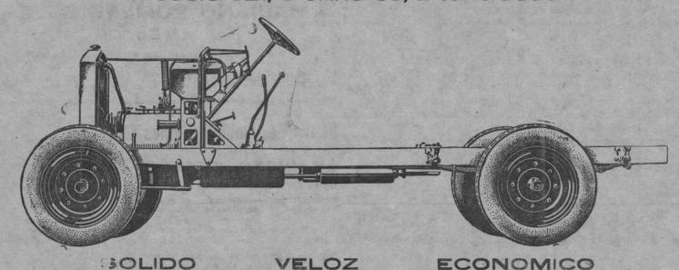
Cigüeñal montado sobre 7 soportes, grupo cilindros al níquel, cromo, frenos independientes, embrague a 4 discos conducidos. Potencia del motor al freno 42 HP. Largo del bastidor, 4,64 m. Espacio para la carrocería, 3,38 m.; gomas sencillas posteriores, 32 × 6. Ruedas de disco. Completamente equipado con guardabarros anterior y posterior, estribos, faldilla, porta-ruedas. Antes de decidir la compra del camión que necesite, pídanos catálogo y precio
