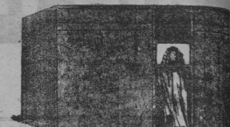
ASPECTO DE UNA CELDA
