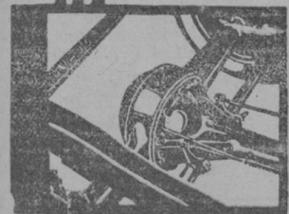
El nuevo eje trasero está encerrado en una sólida cubierta, provista de una tapa de inspección
