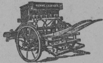
Las más favoritas para ser empleadas en esta Región puesto que además de ser sus rejas de acero flexibles y poderse ajustar para sembrar a distintos anchos, sirven a la vez para cultivador, ya que solo sacando dos tornillos desaparecen los tubos de acero flexibles conductores de la semilla y están convertidas ya para cultivar los terrenos que la misma haya sembrado.
