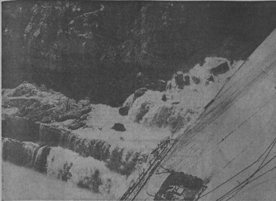
La filtración de agua produjo un torrente de 15.000 litros por segundo, que rompió el terreno junto al estribo derecho de la presa.
