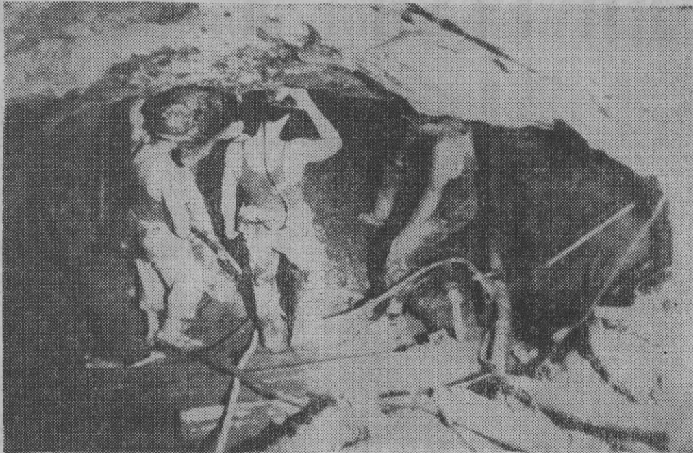
Una galería horizontal está siendo excavada por los equipos de socorro. (Foto Fiel.)
