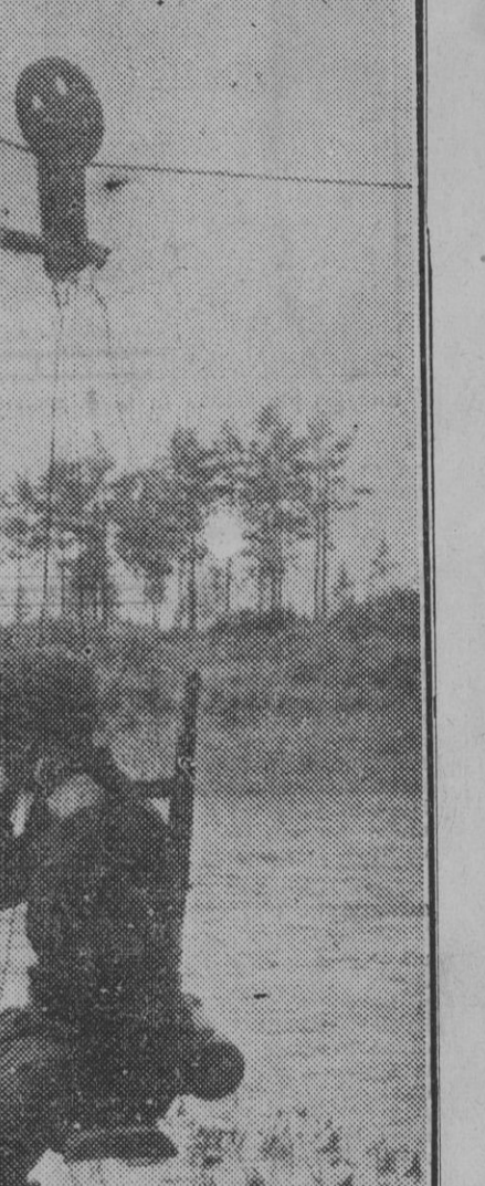
Para atravesar los rios, los ingenieros alemanos emplean con frecuencia estos funiculares individuales. (Foto Orbis.)
