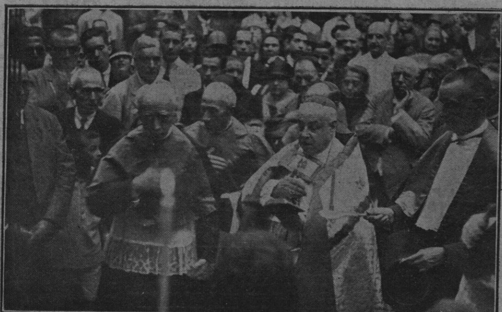
El Excmo. Obispo de Lérida y Coadjutor de Barcelona, Dr. Miralles, efectuando la bendición de la primera piedra del Circulo de Obreros Católicos
