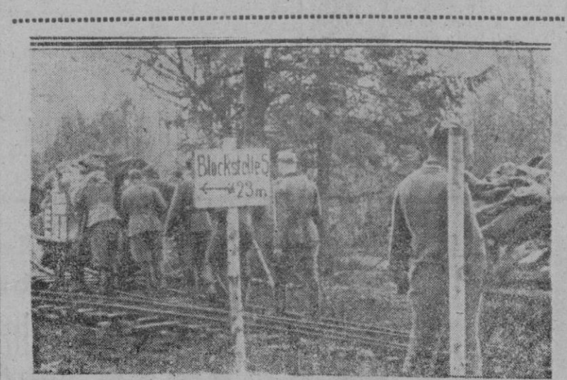
EL "EXPRESO DEL VOLCHOV".—Las tropas alemanas del Volchov, para vencer las dificultades del barro, han construido esta original línea férrea. Los caballos tiran de las vagonetas, y a veces empujan los soldados. Pero el humor llama a esto, con gran renombre, el "Expreso del Volchov".—Foto PRESAMUNDO.
