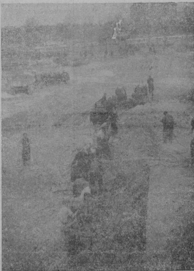
LA DESAPARICION DEFINITIVA DE LAS FORTIFICACIONES DE PARIS. — Los últimos vestigios de las fortificaciones parisienses son demolidas activamente en la Porte de Clichy. Vista general de una muralla. (Express Foto)
