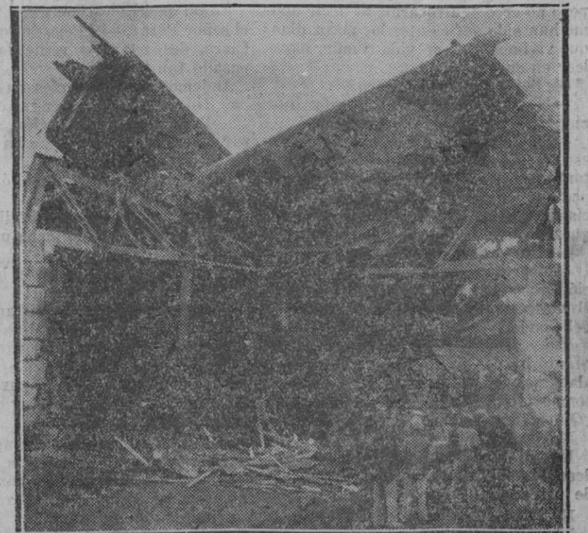
VALENCIA. — LA CATA STROFE DE PUZOL. — El expreso Valencia - Barcelona caído a consecuencia de la salvaje destrucción del puente
