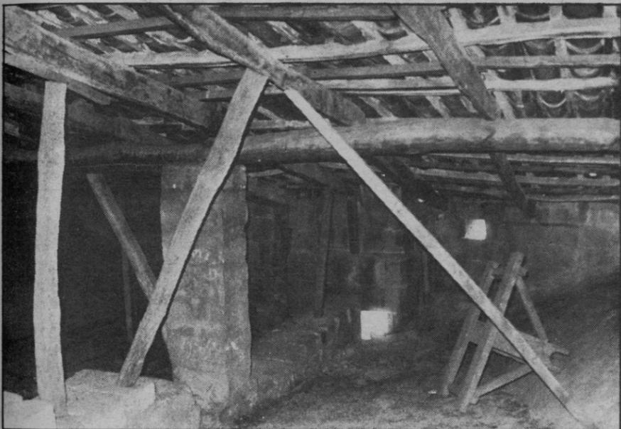
La cubierta de teja que data del siglo XVIII será sustituida por un entramado de acero que se apoyará en los mismos puntos que la actual que ha tenido que ser apuntalada debido a su imparable degradación
