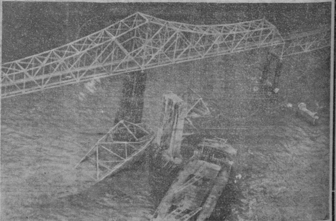
MIAMI (ESTADOS UNIDOS). -- Treinta personas resultaron muertas, por el momento, en el accidente ocurrido en la Bahía de Tampa, cuando un buque cisterna chocó contra el puente sobre la misma y destruyó una de sus secciones. Un autobús, con 23 pasajeros, y varios automóviles que por allí circulaban en esos momentos cayeron al agua, desde una altura de 50 metros. Por el momento sólo una persona ha logrado salir con vida. -- (En la foto, el buque cisterna tras chocar contra la sección del puente. Telefoto EFE-UPI).
