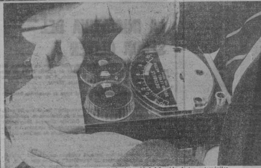
Sonómetro, aparato para medir la intensidad del ruido de los automóviles.
