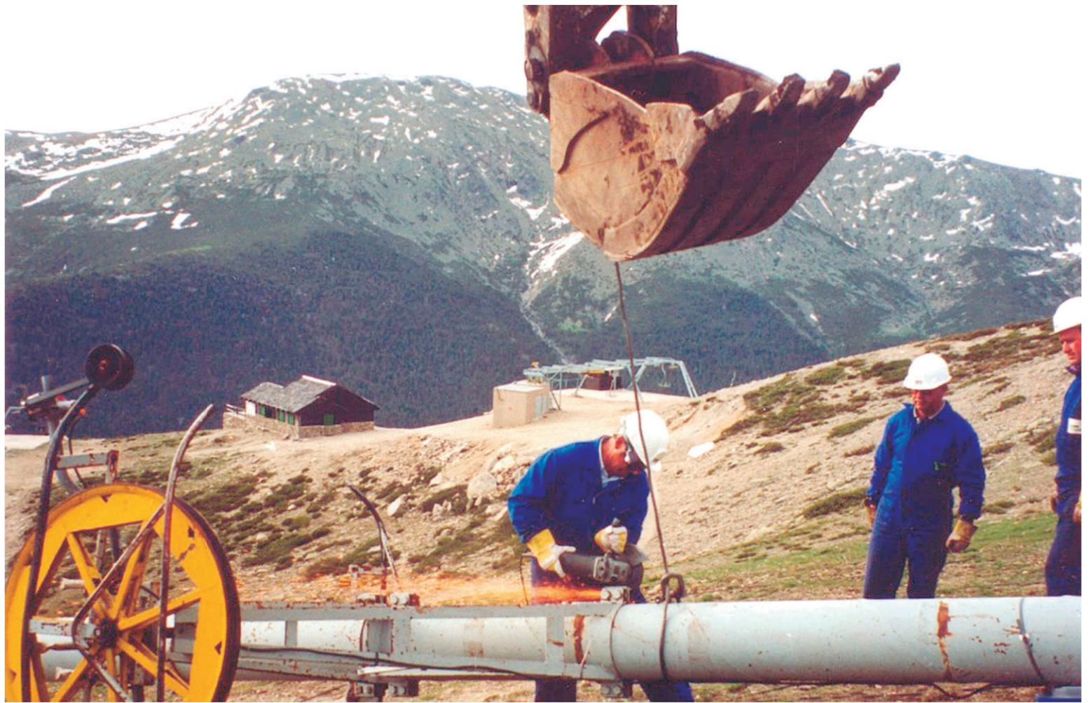
Los trabajadores desmontan una de las tuberías que canalizaban el agua en la antigua estación de Valcotos.
