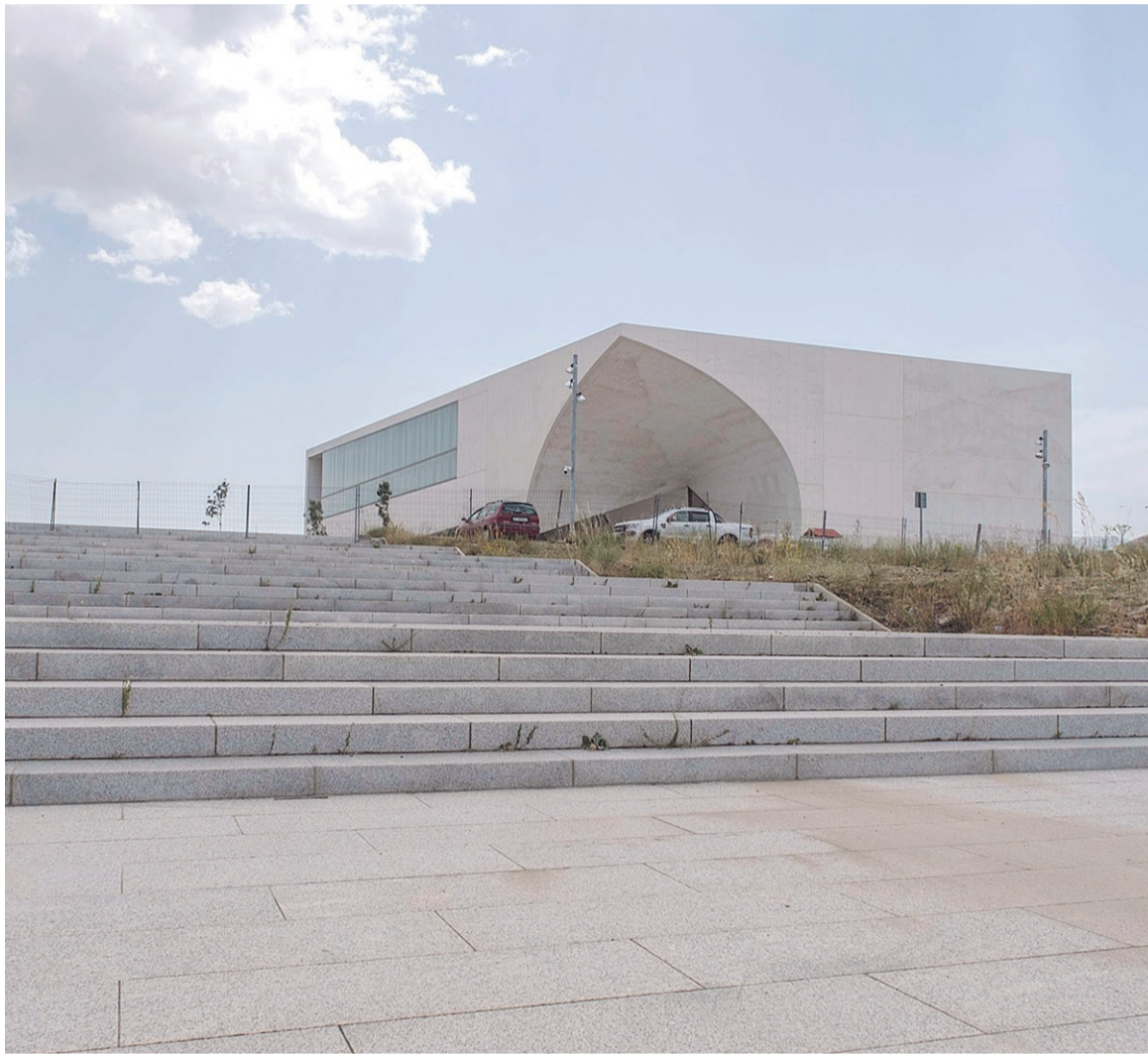
El Ayuntamiento ha adjudicado algunos contratos menores para mejoras en el entorno del edificio.
