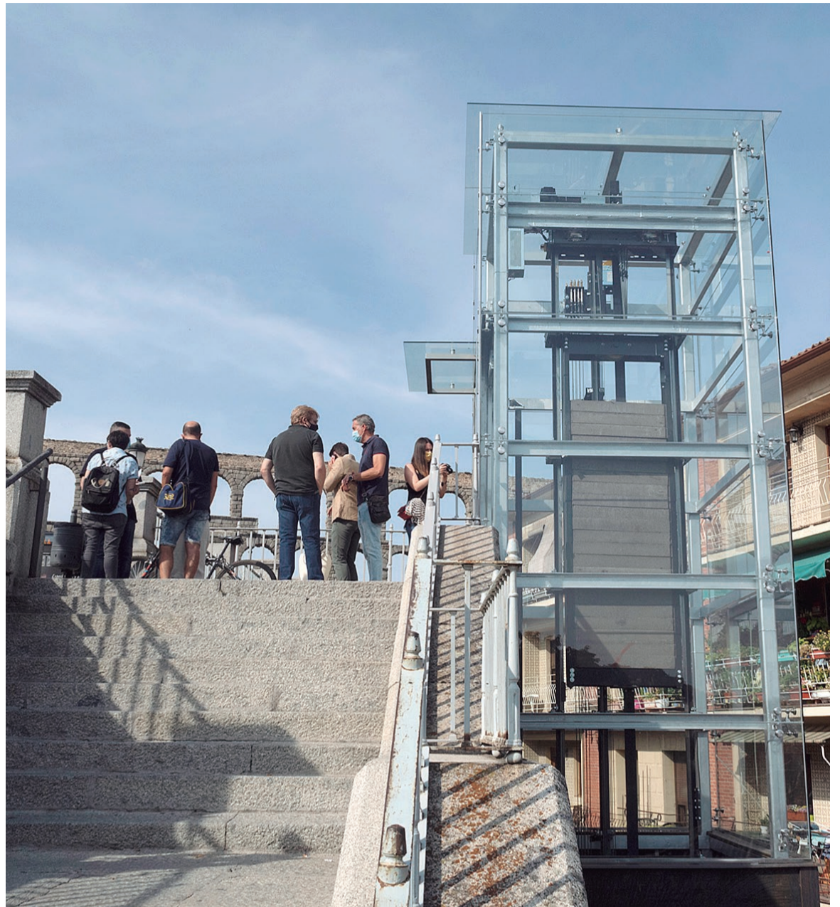
El ascensor de la calle Gascos ha sido uno de los proyectos más destacados del año en la ciudad.
