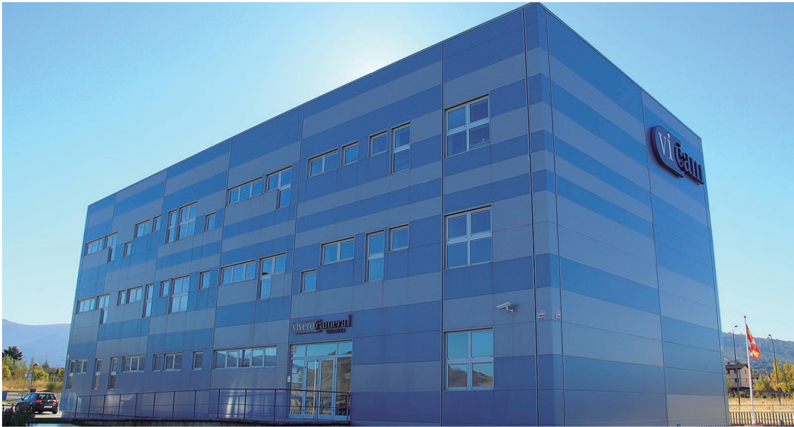
La Diputación exoneró desde marzo el alquiler de las 17 empresas instaladas en las oficinas del edificio VICAM.
