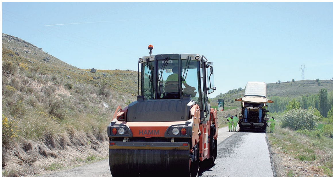
Obras de conservación en una carretera de la provincia.
