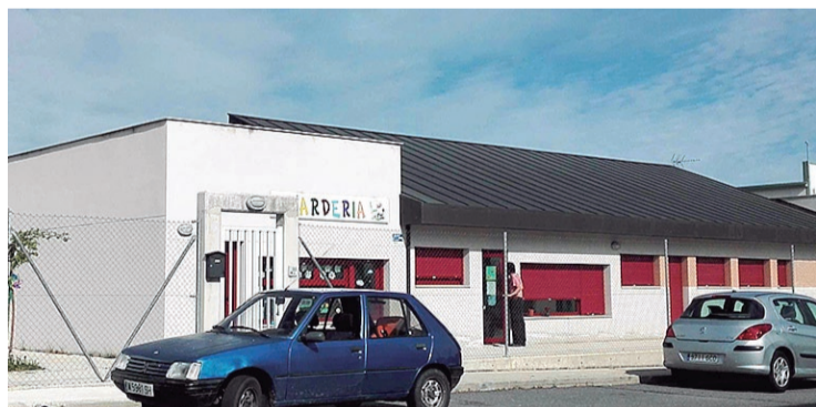
La guardería se ubica en el polígono industrial de la localidad.
