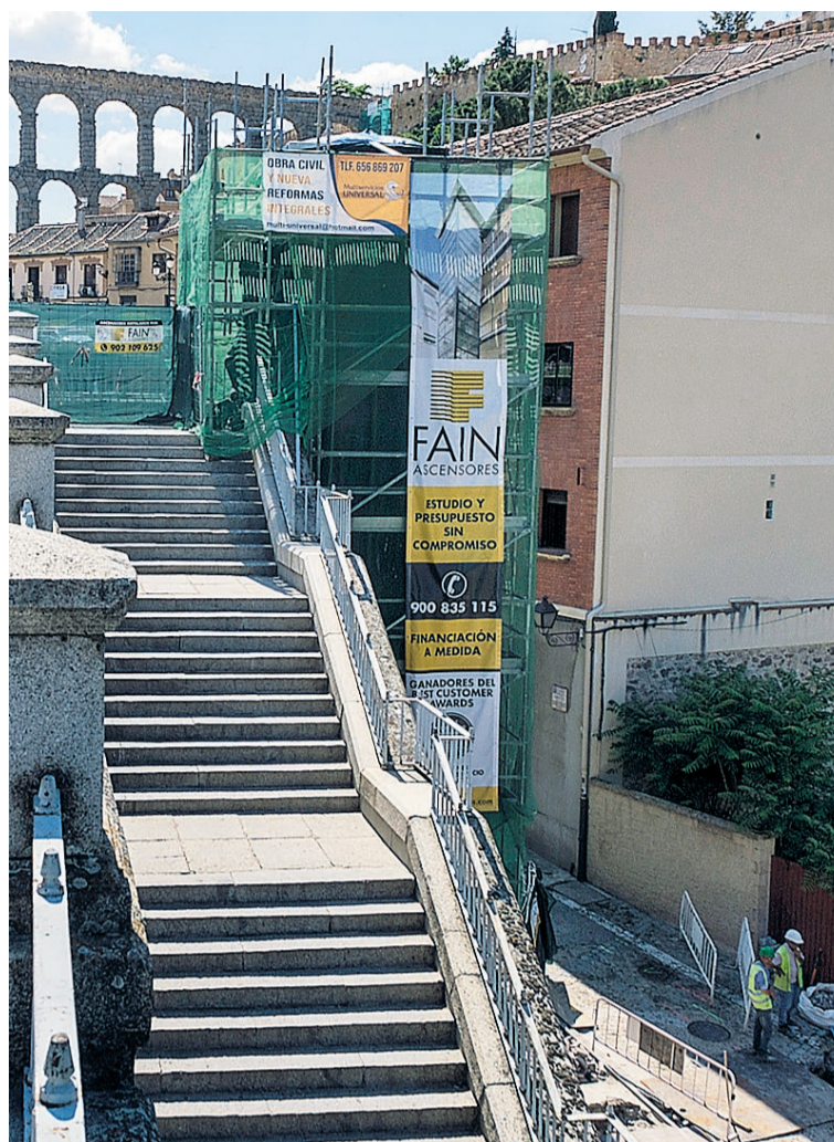
Estado de ejecución del ascensor de la calle de Gascos.
