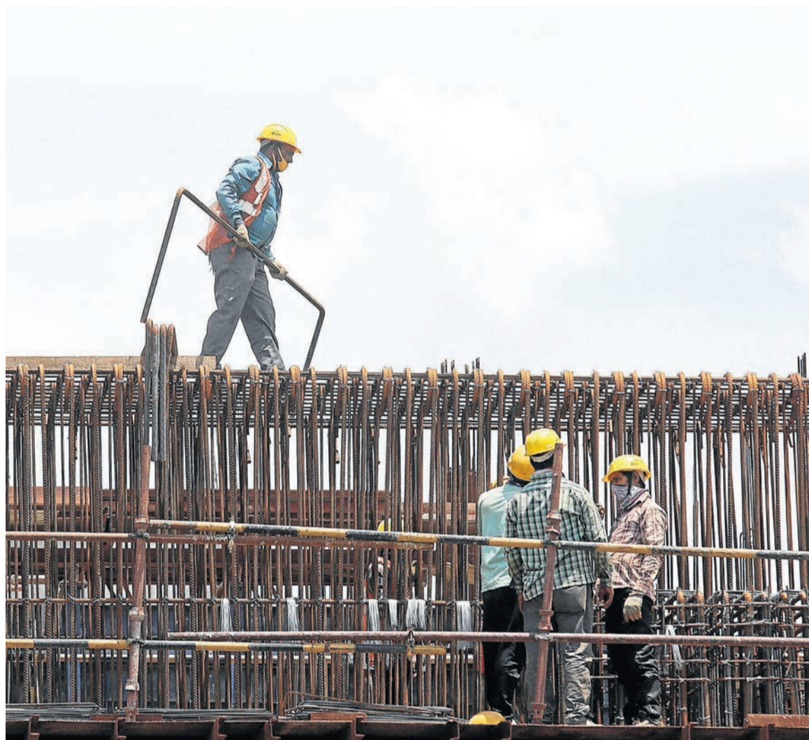
Trabajadores en un edificio en construcción.
