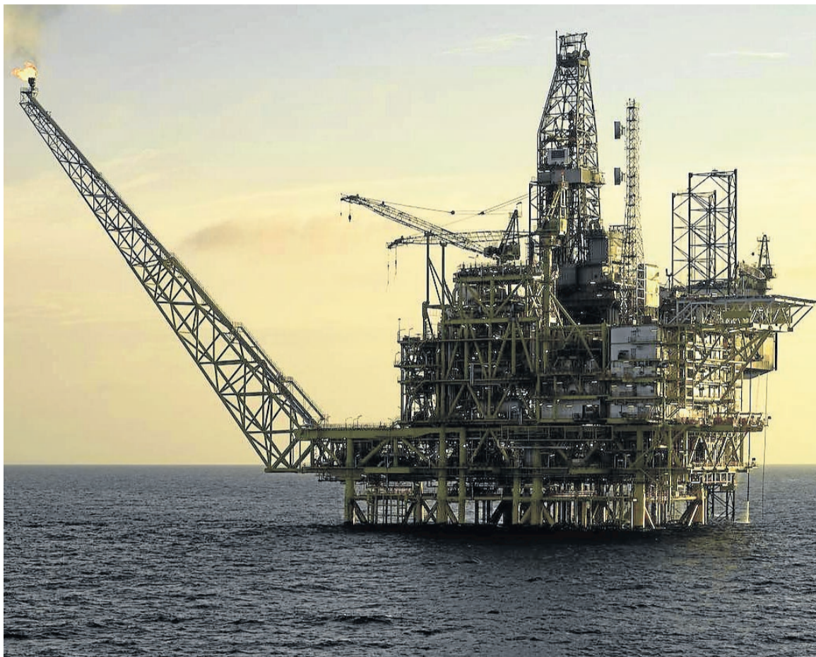
Una plataforma petrolífera situada sobre el mar.
