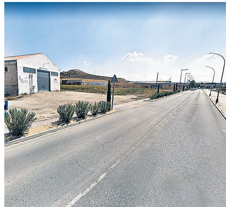
Carretera de Segovia, lugar en el que se realizará el proyecto.
