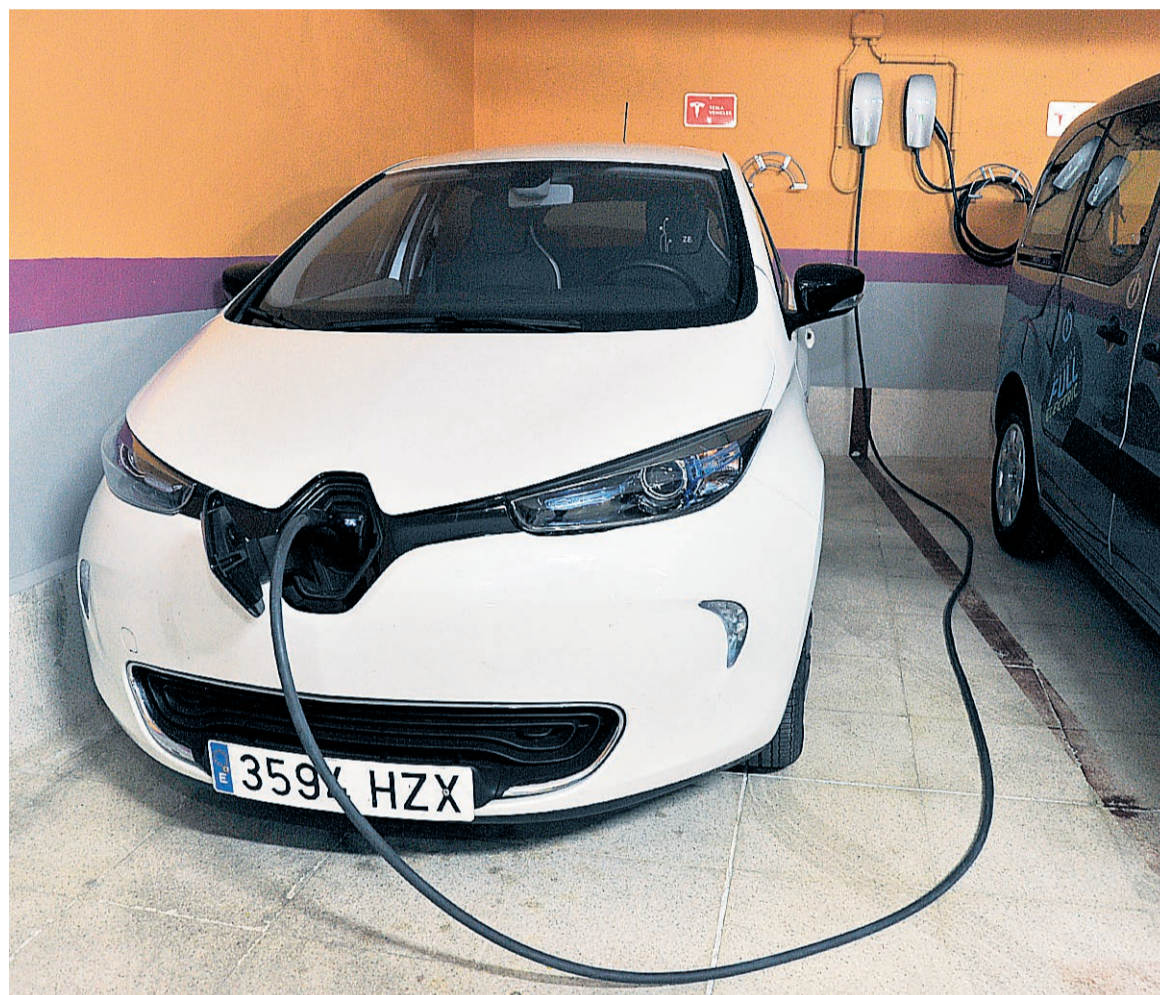
Un vehículo eléctrico, durante las tareas de recarga de sus baterías en el parking de un hotel de la capital. KAMARERO
