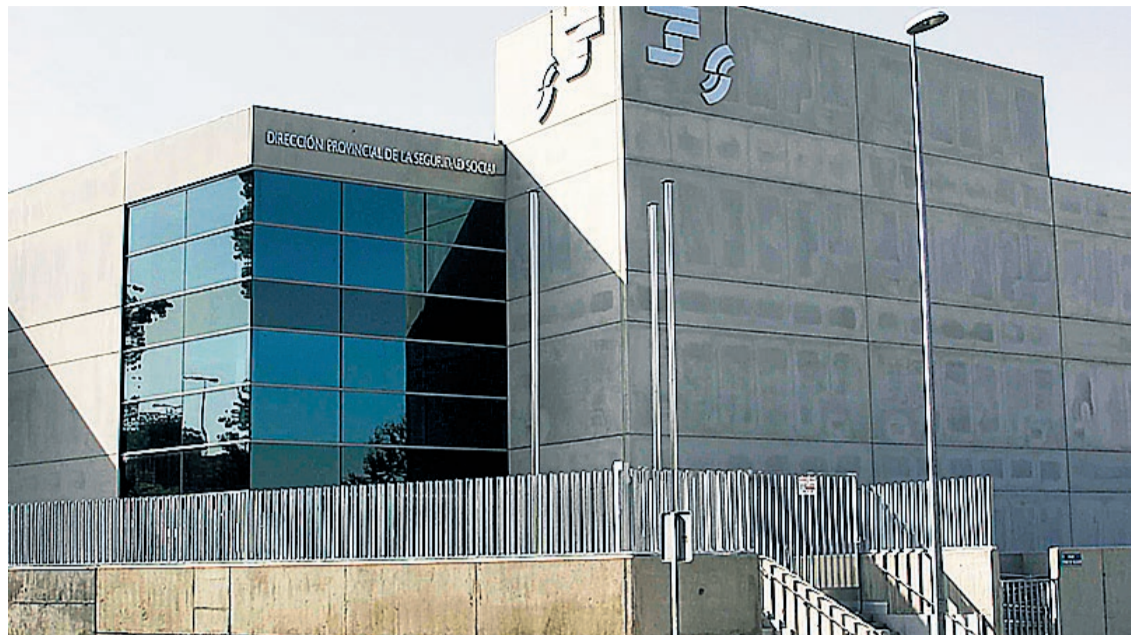
El edificio cederá su espacio para la celebración de la vista oral, dadas las características del proceso
