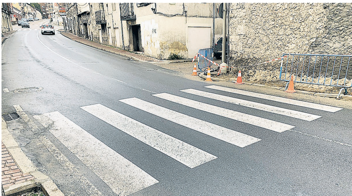
Obras de rebaje de bordillos en la Avenida Camilo José Cela.
