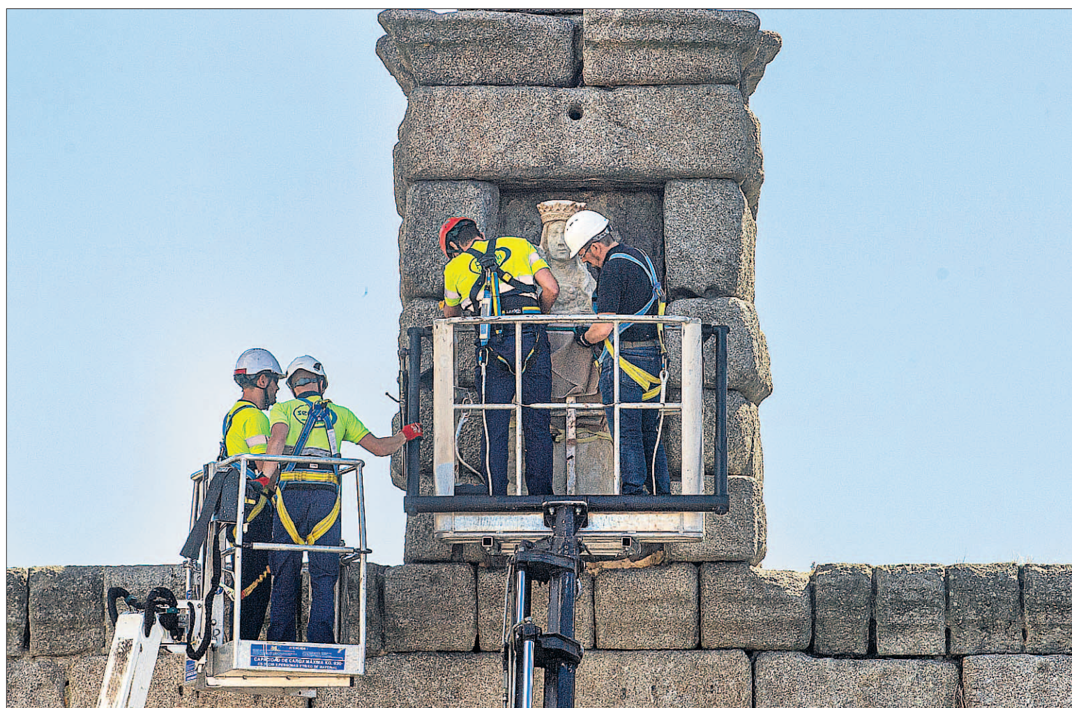
Hasta cuatro técnicos participaron ayer en los trabajos de colocación de la réplica de la Virgen del Acueducto en la hornacina del monumento. / KAMARERO
