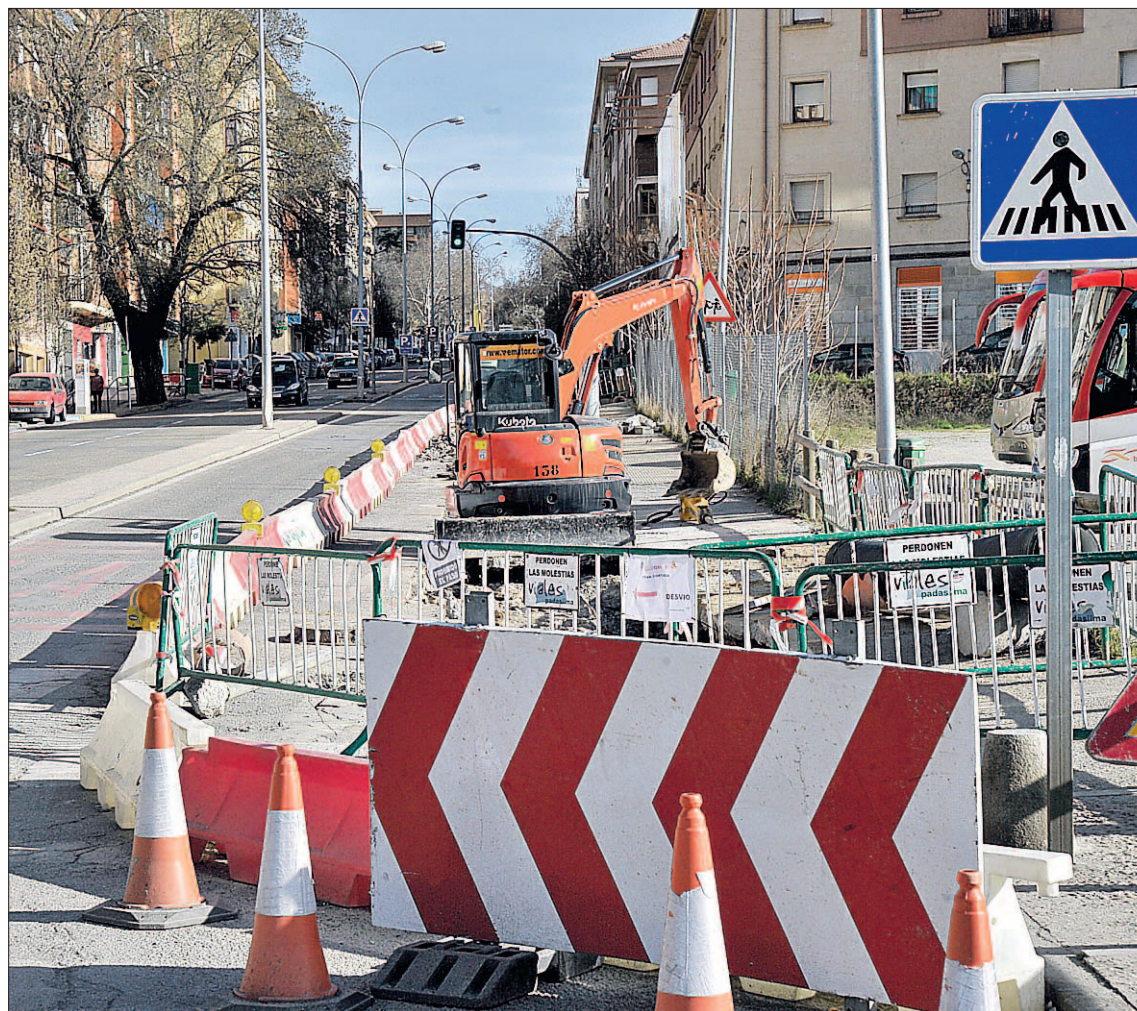
Imagen del paseo Ezequiel González, con las obras en uno de sus carriles. / KAMARERO
